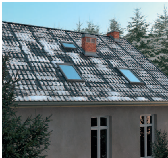
1.3. Przykład występowania mostków ciepłych – stopiony śnieg w miejscach przenikania ciepła przez krokwie na dachu
