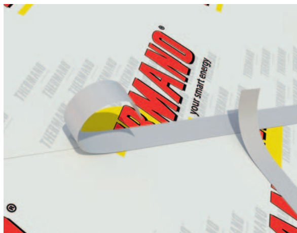
4.6. Taśma samoprzylepna zwiększa szczelność pokrycia
