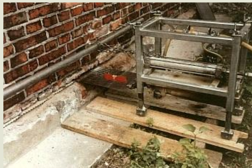
Urządzenie do wbijania blach w spoiny muru
