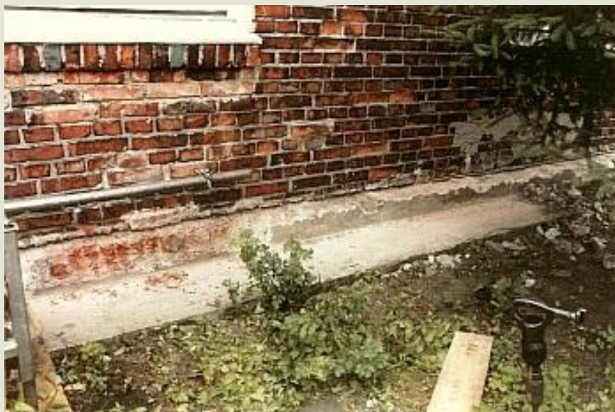
Przygotowanie odcinka ściany budynku do wprowadzenia blach w spoiny muru
