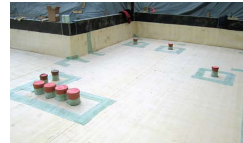
Wykonane wewnętrzne połączenia membrany wokół detalu
