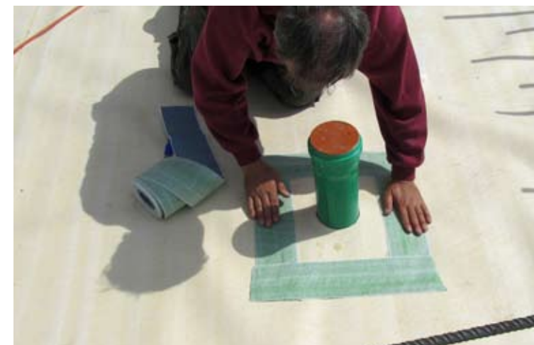
Wewnętrzne połączenie membrany za pomocą taśmy SikaProof® Tape -150 wokół detalu
