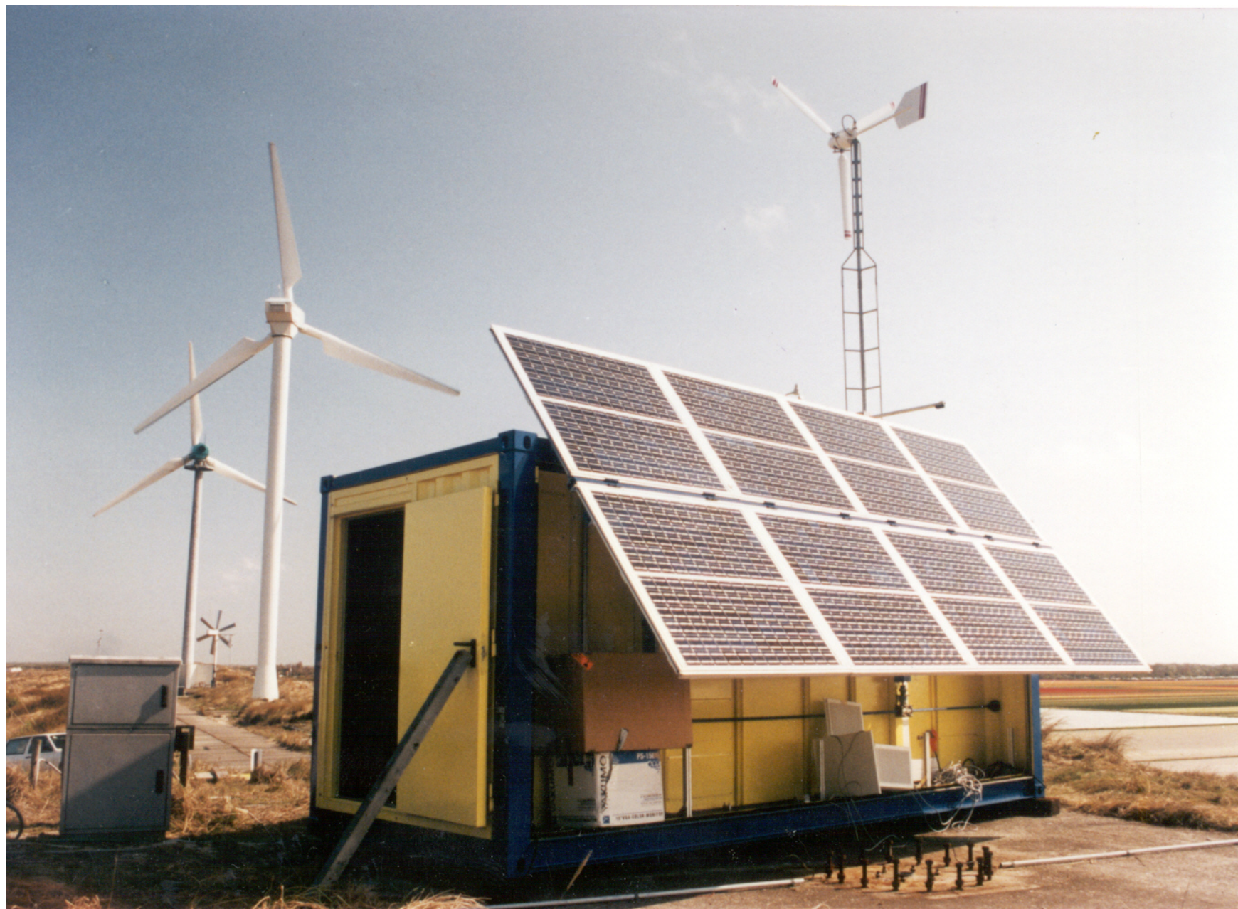
Indonezja- system pompowania wody, zasilany elektrownią hybrydową (Źródło: www.ecn.nl )
